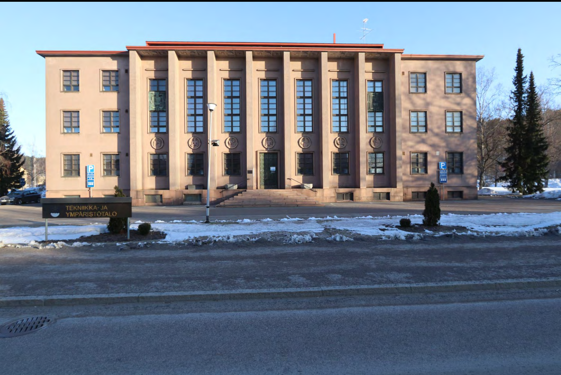
Kuusankosken kunnantalo, arkkitehti Georg Jägerroos 1932
